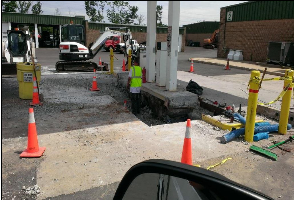
DOT & I Facility New concrete pour
